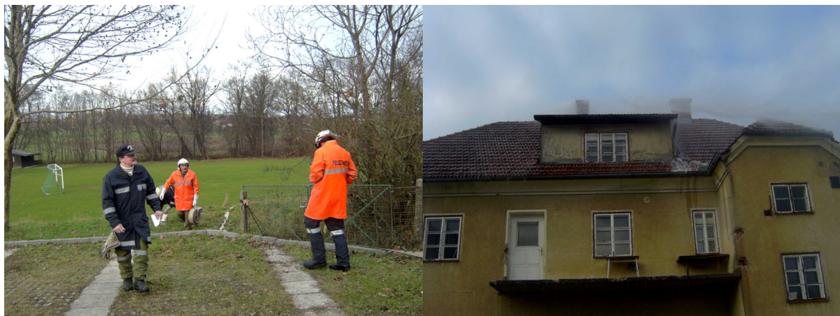
Schlussübung beim 92er Haus vor Abriss
